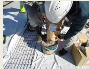
主剤・硬化剤を攪拌、特殊骨材を入れ攪拌
