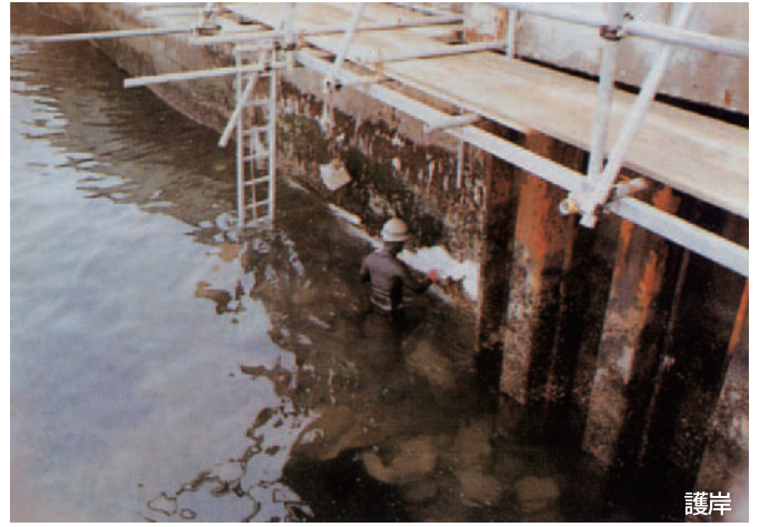
漏水個所の二次止水
