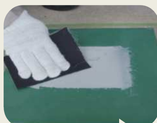
細かな突起、段差を削って下さい
