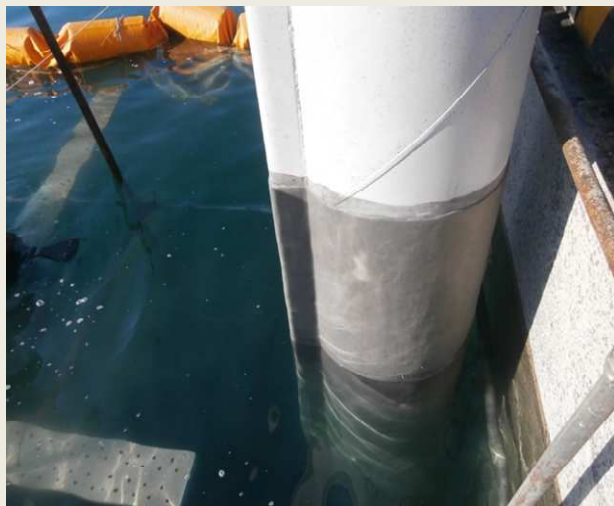
鋼管杭の防食ライニング
