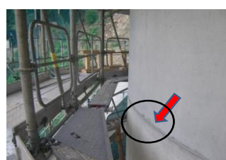
橋脚充填接着部
