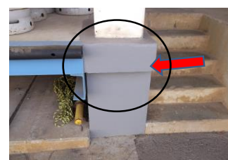
基礎欠損補修部
