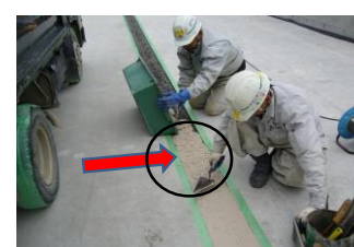
橋面断面修復部
