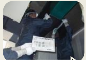
繊維シート貼付
