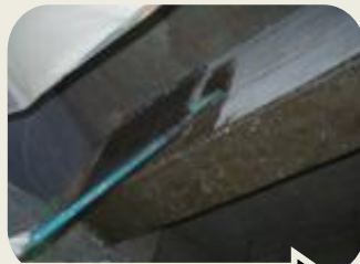
プライマー塗布
