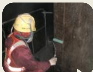
プライマー塗布
