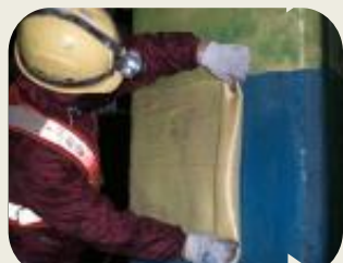
繊維シート貼付
