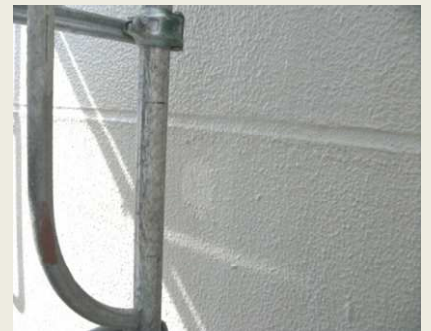
⑥ 補修完了
