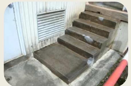
階段の欠損部補修
