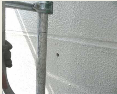
② つなぎ撤去
