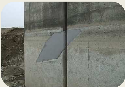
壁面の断面修復
