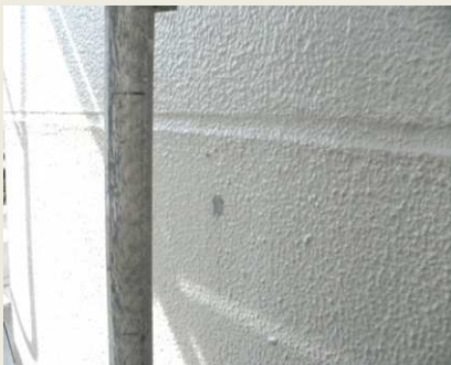
④ A-1010充填完了
