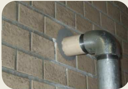
ガス管壁貫通孔周り補修
