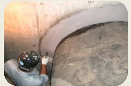
水道管壁貫通孔周り補修
