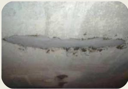
天井面の断面修復
